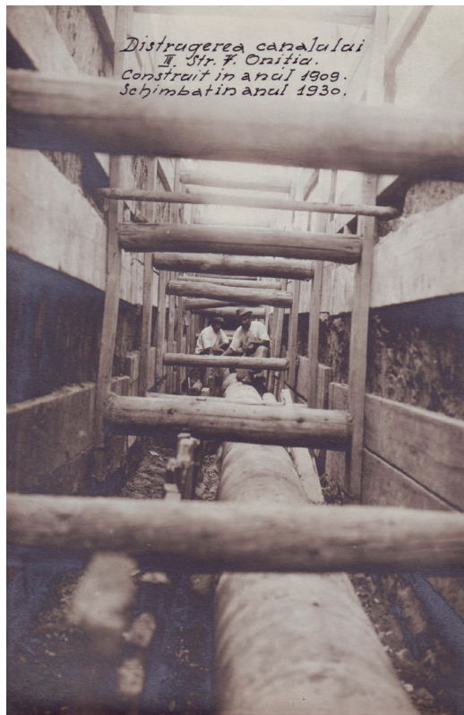
Fotografii din timpul construcției sistemului de canalizare
