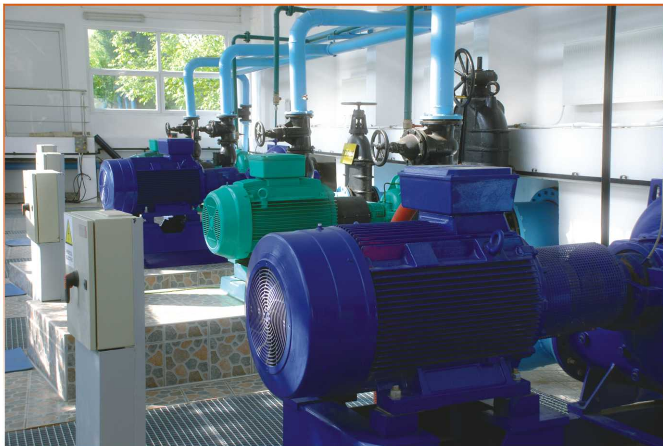
Stația de pompare nouă de la ST Urseni a redus consumul energetic local cu 17,5%
