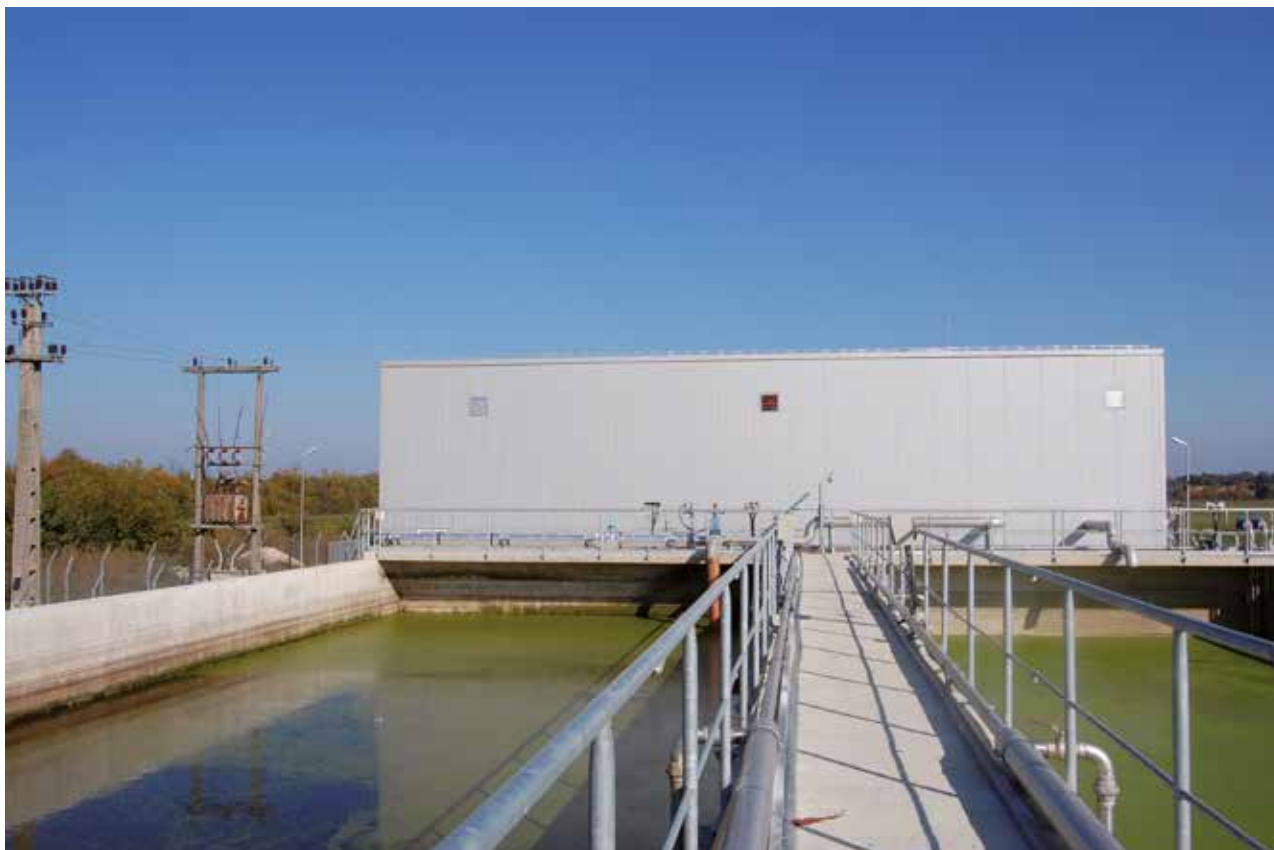
Stație nouă de epurare a apei uzate, în Deta, construită prin POS Mediu
