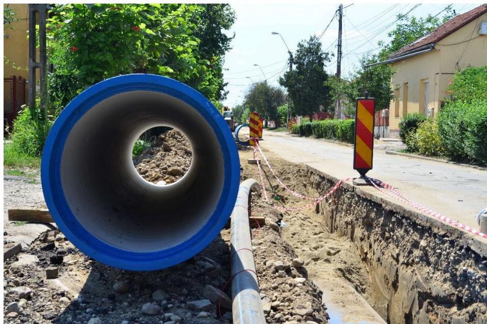
Modernizarea rețelei de apă în cartierul Freidorf. Sursa: arhiva Aquatim
