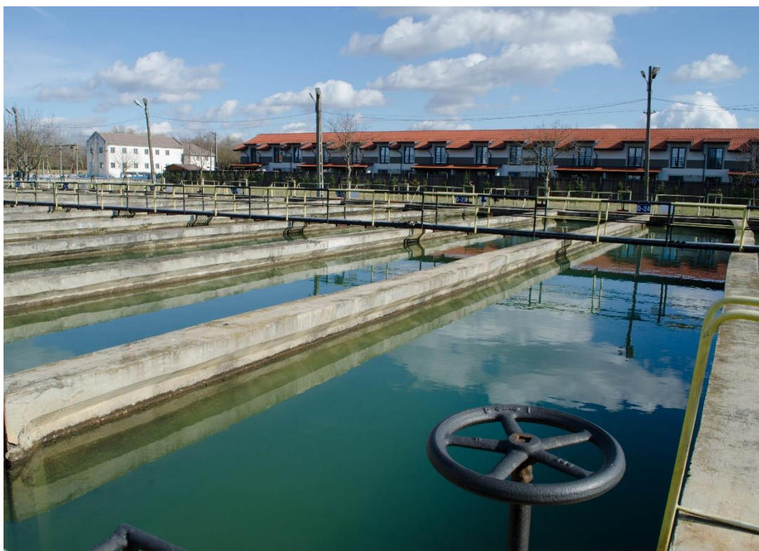
Stația de tratare Bega, Timișoara. Sursa: Aquatim
