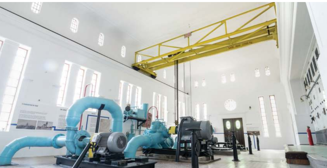
Foto: Mircea Pap. Sala mașinilor, Uzina de Apă Industrială
