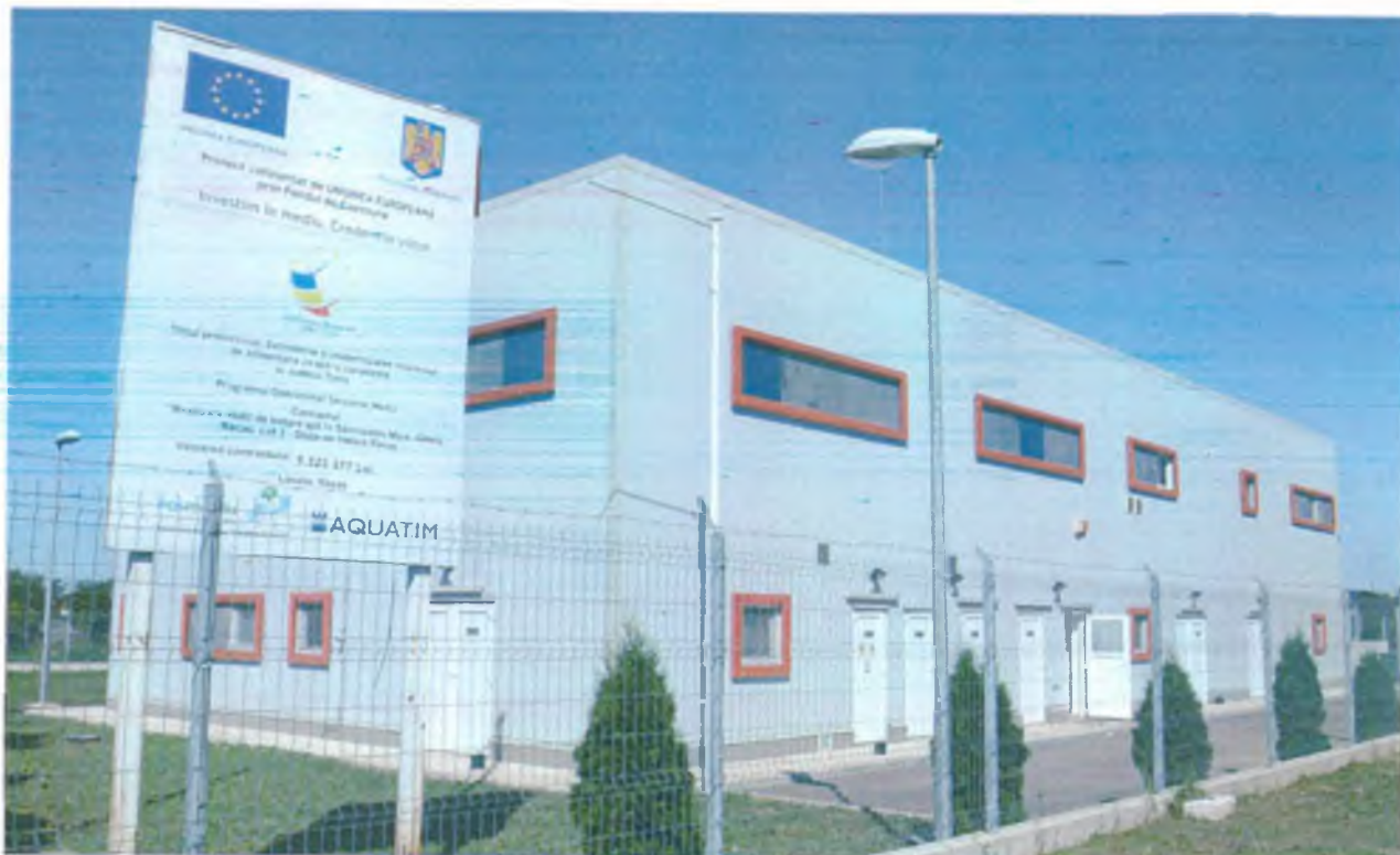
Poza 1. Stația de tratare a apei – Recaş
