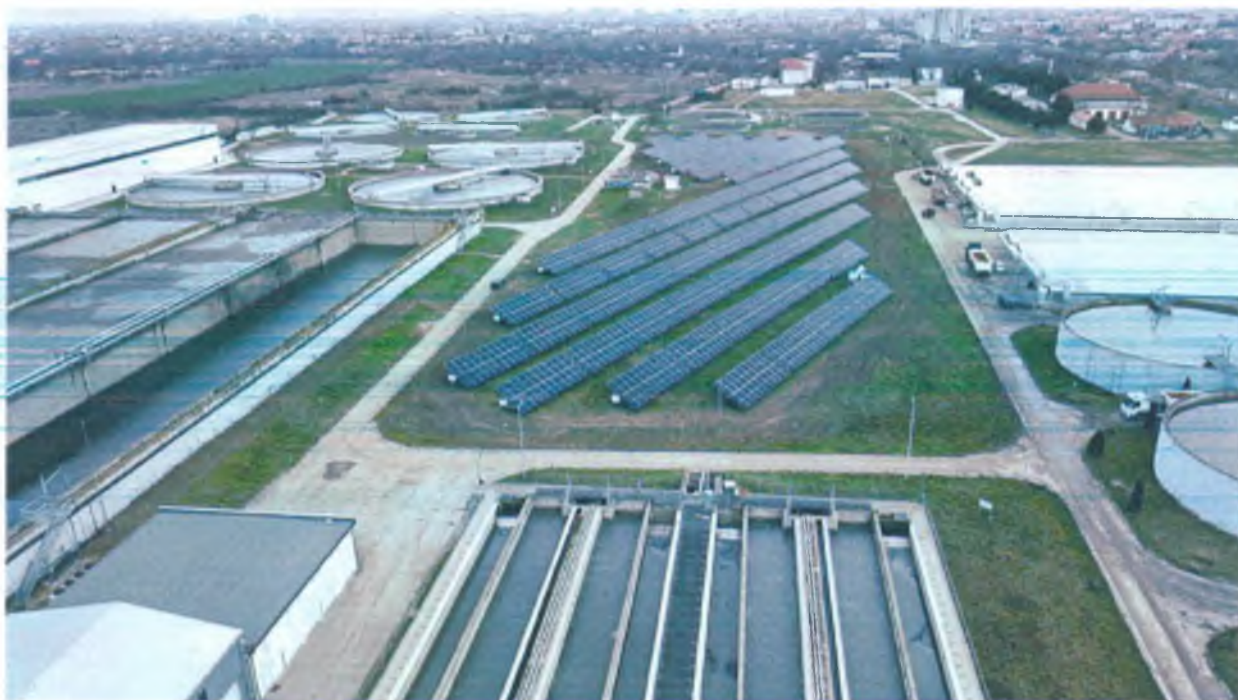
Poza 5. Stația de epurare Timișoara
