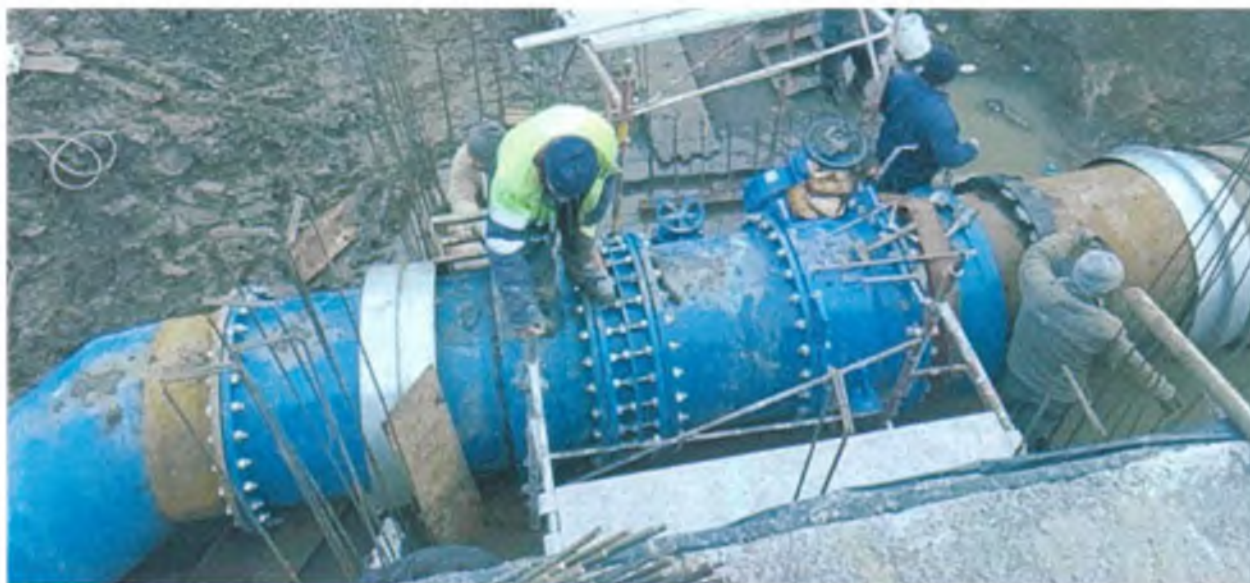
Poza 6. Lucrări de modernizare rețea
